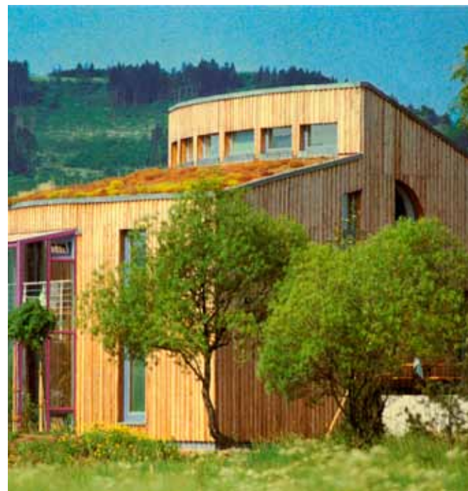
Tweegezinswoning: groen dak met 30 cm isolatie; muren in snelbouw met 16 cm isolatie + Celit 3D isolatiebeschermplaat
